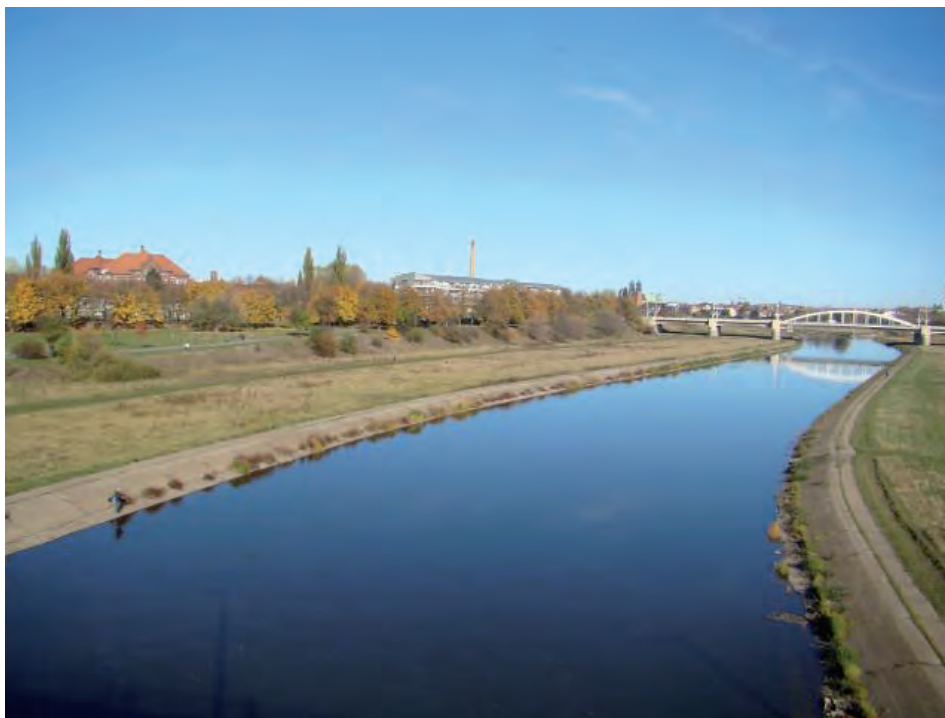
Ryc. 3. Widok na rzekę Wartę z mostu Królowej Jadwigi w stronę mostu św. Rocha (fot. D. Dymek)
