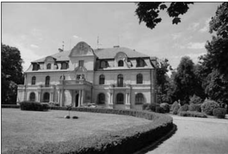
Fot. 1. Założenie pałacowo-parkowe w Smolicach – elewacja wschodnia. Fot. I. Markuszewska
