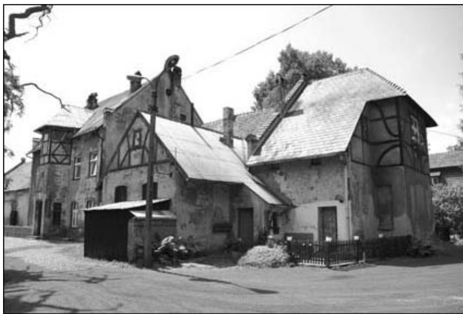
Fot. 7. Założenie pałacowo-parkowe w Borzęcizkach – dawne zabudowania gospodarcze. Fot. I. Markuszewska Phot. 7. The palace-park complex in Borzęcizki – former farm buildings. Phot. by I. Markuszewska
